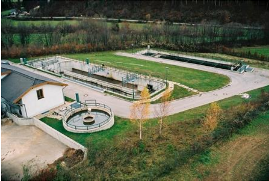
Kläranlage Alland © Georg Windhofer/Umweltbundesamt
