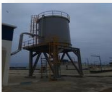
Silo de stockage des boues au niveau de la STEP d'Al Hoceima
